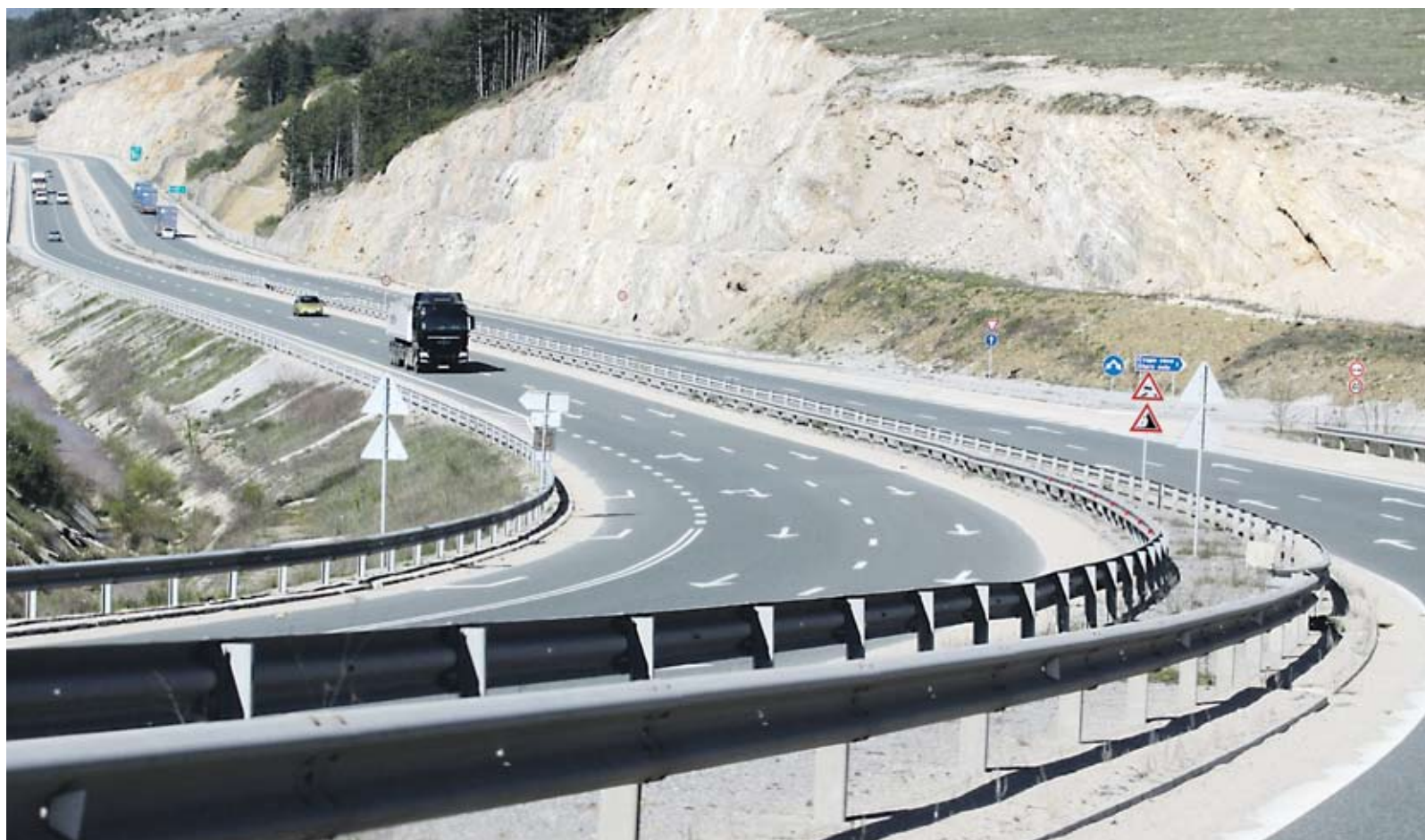
► Магистрала "Струма" ще донесе бизнес на строителите и приходи за всички, които ще обслужват стоквите потоци, пътуващи от Европа към Гърция и обратно
