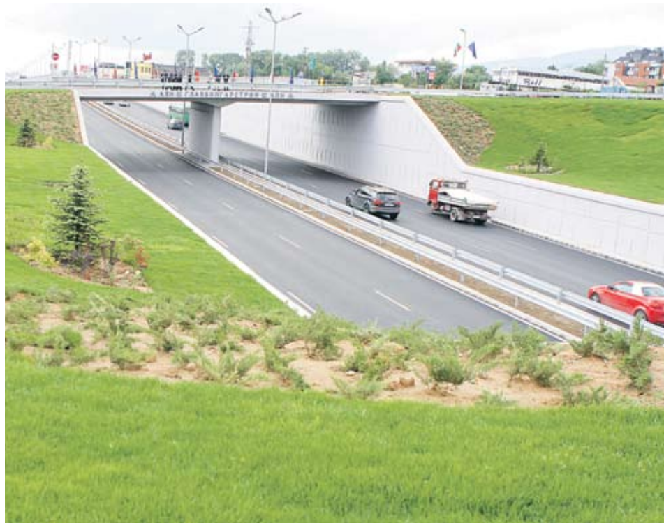
► Ремонтът на Северната тангента на околоръстното бе завършен на 5 юни, след месец пътна настилка беше започнала да се разрушава СНИМКА МАРИНА АНГЕЛОВА
