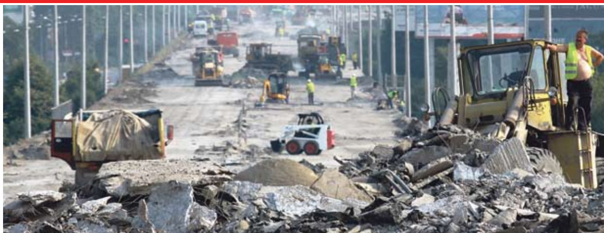
Преди 2 години бул. "Брюксел" бе ремонтиран ударно и за 2 седмици бе сменен асфалтът му. Сега се осъществява и подмяна на хидроизолациите и отводнителните съоръжения
