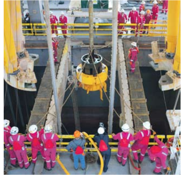
► Работниците на ВР поставиха 75-тонен стоманен похлупак върху разрушения кладенец в Мексиканския залив
